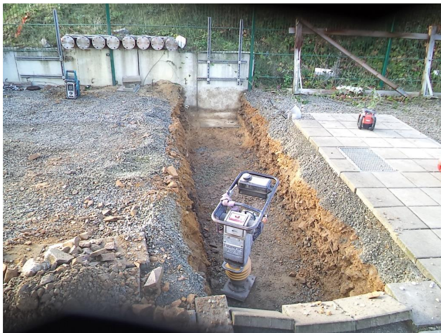
Abbildung 2: Herstellen der Fundamente – Aushub und Verdichtung
