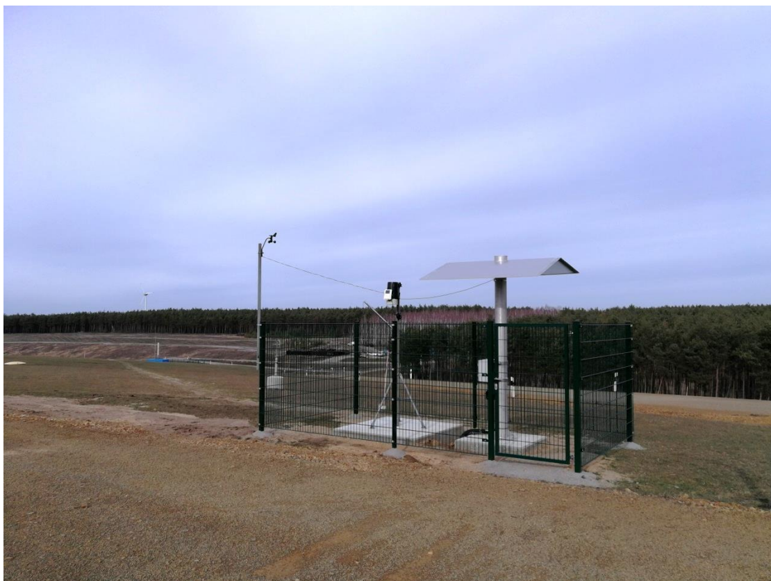
Abbildung 23: Messstation auf der Deponie
