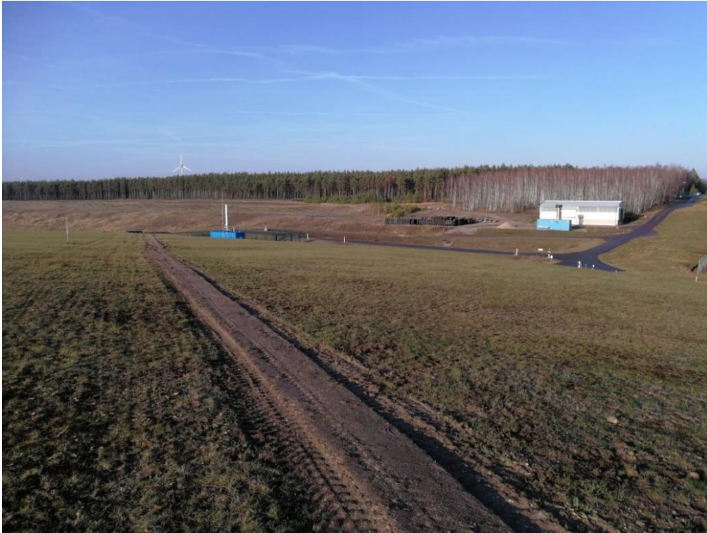
Abbildung 22: Nach dem Verfüllen des Kabelgrabens wurde die Trasse neu angesät.
