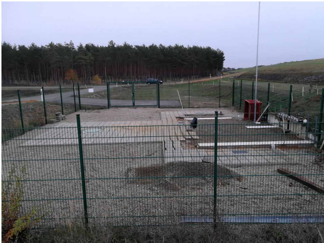
Abbildung 4: Fertig gestellte Fundamente
