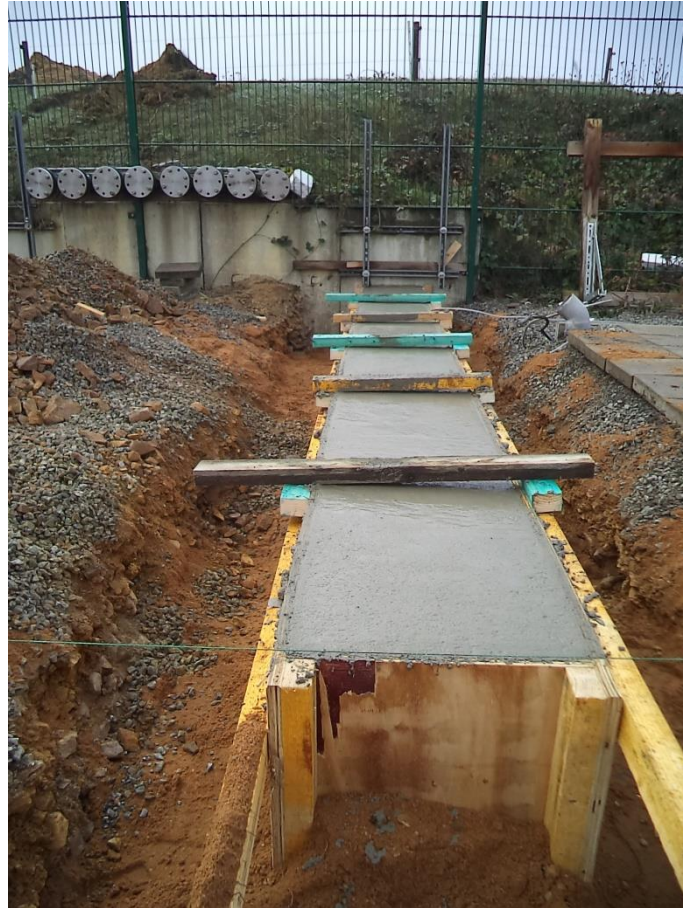
Abbildung 3: Ausgegossen mit Beton
