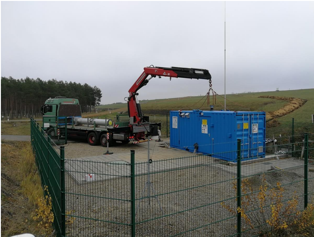
Abbildung 5: Abladen und Aufstellen der Anlage
