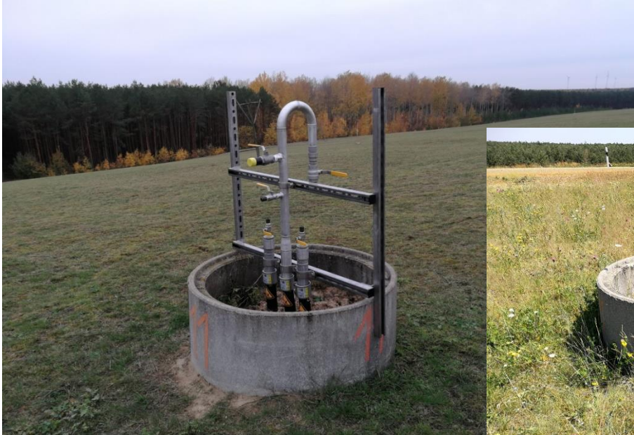
Abbildung 25: Umrüstung der Multilevelpegel mit Belüftungsrohr
