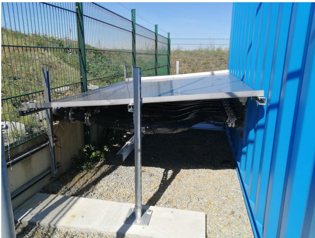
Abbildung 8: Abdeckblech und Isolierung
