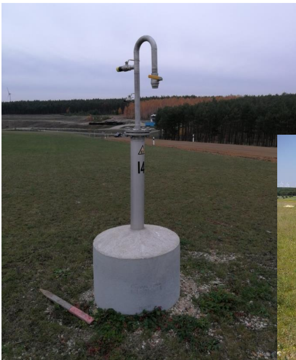
Abbildung 27: Umrüstung der Gaspegel mit Belüftungsrohr
