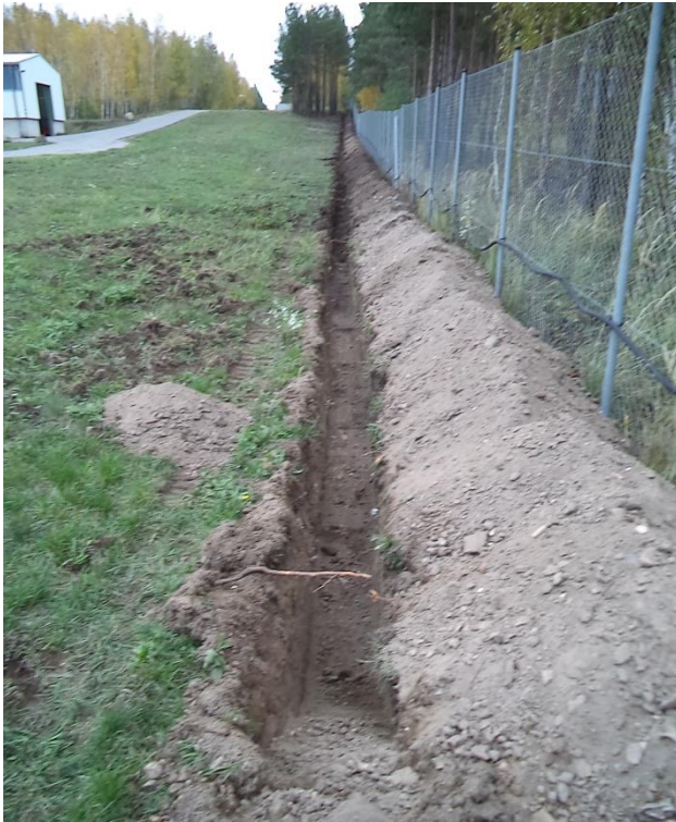
Abbildung 9: Aushub Kabelgraben
