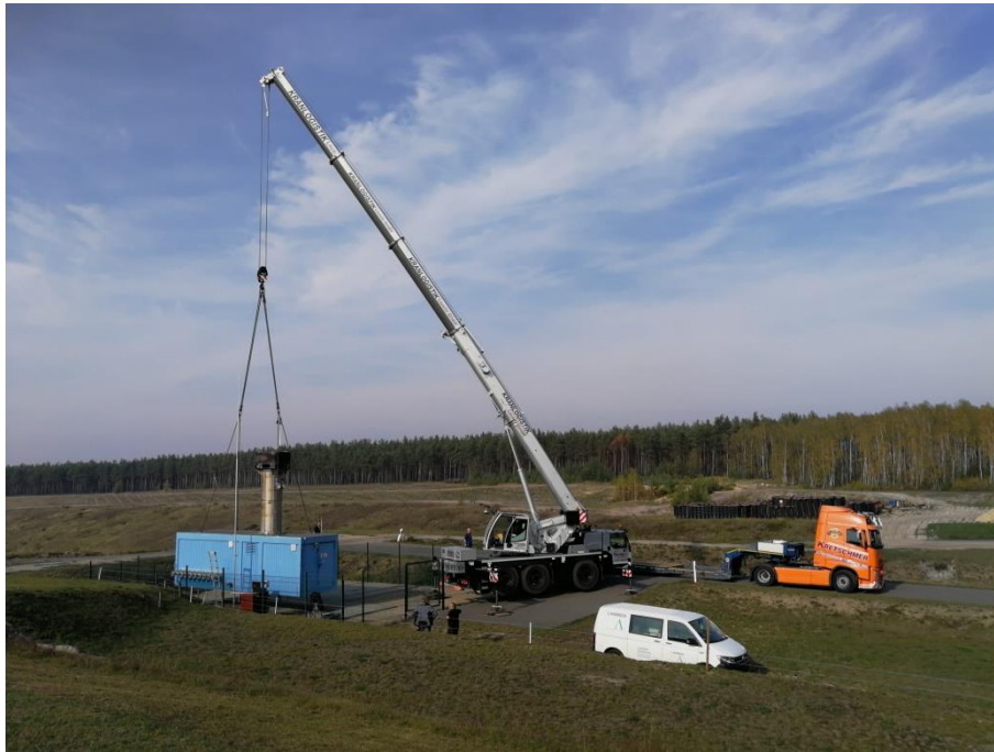
Abbildung 1: Laden des Fackelcontainers
