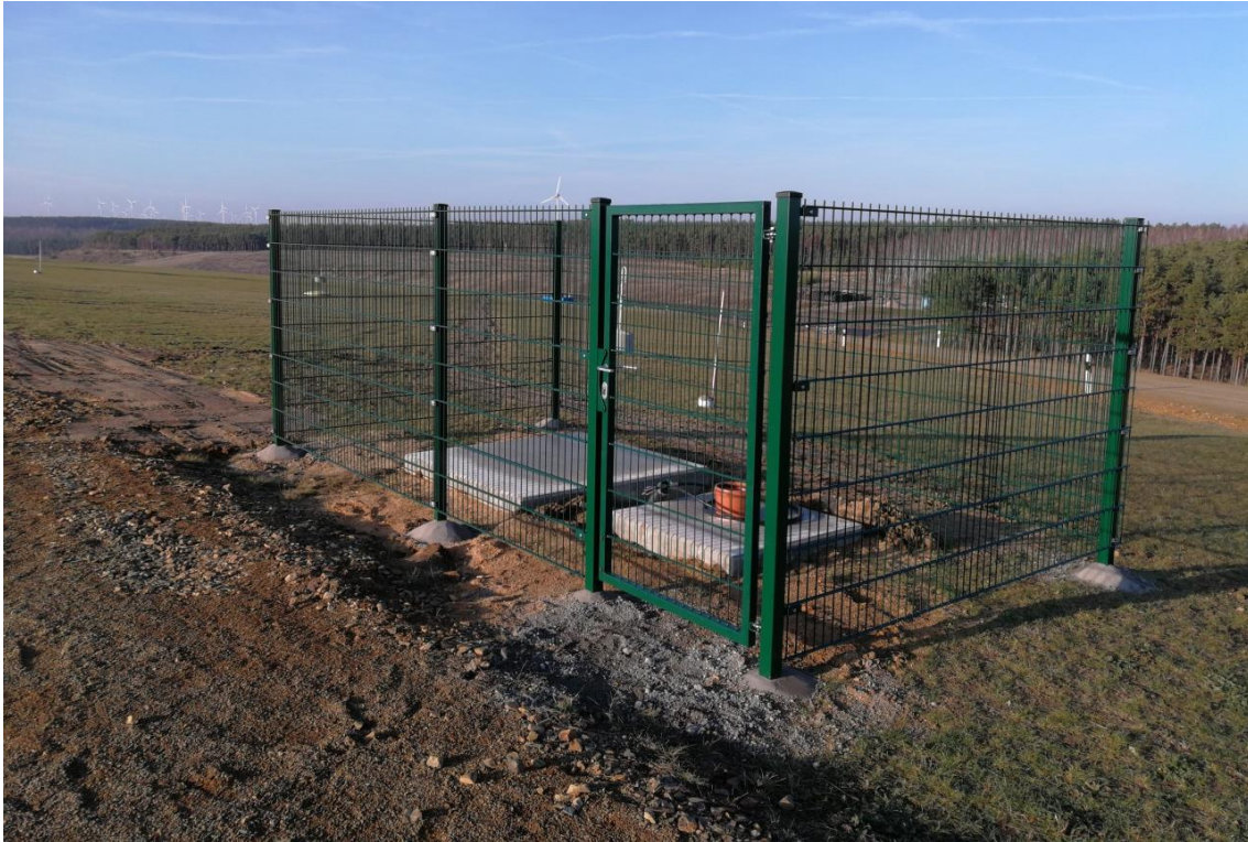
Abbildung 19: Zaun und Fundamente fertig gestellt
